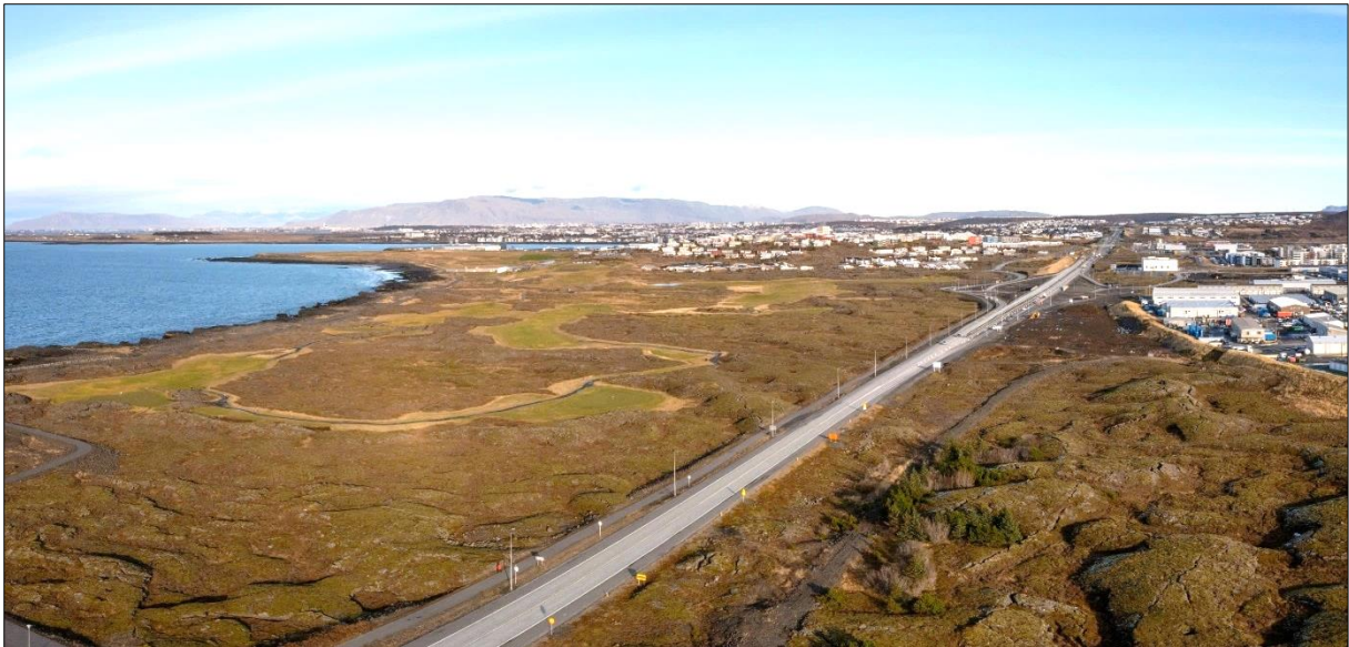
Mynd 6.9 Hraunið, Hvaleyrargolfvöllur og Reykjanesbraut. Horft í átt að Hafnarfirði.
